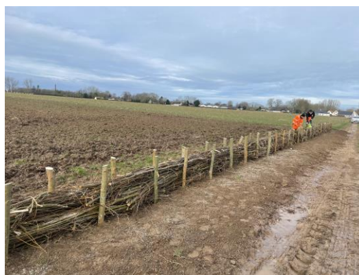
Réalisation des fascines
